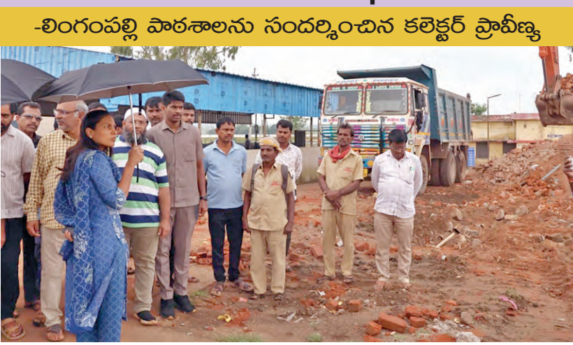
కూలిన భవన శిథిలాలను లోలగింపు పనులను పరిశీలిస్తున్న కలెక్టర్
